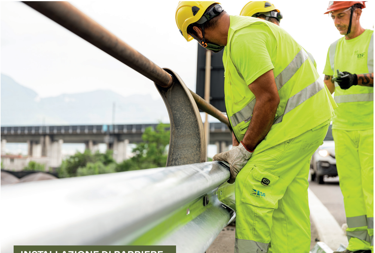
INSTALLAZIONE DI BARRIERE
