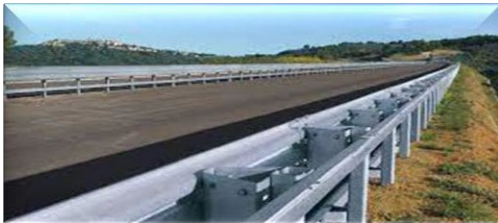
Installazione di barriere
